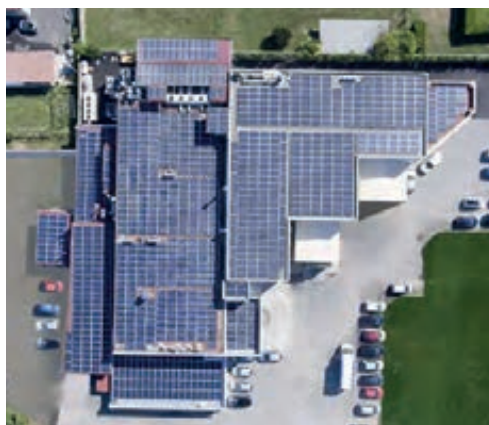
PANNELLI SOLARI L'azienda utilizza pannelli solari per il rispetto dell'ambiente.
